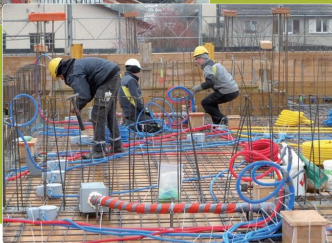
Betondecke vor dem Betonieren mit vielen Einlagen
